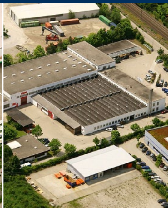
Fertigung und Lager 3 (SAHLBERG Polymer und Fluid Center)
