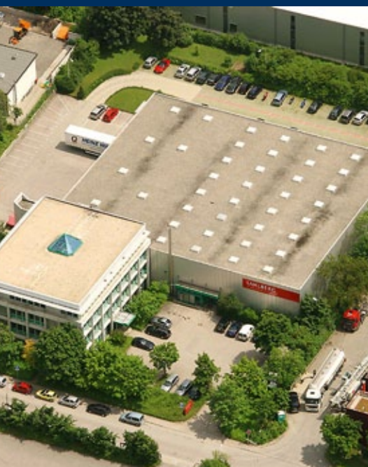
Zentrale und Lager 1
