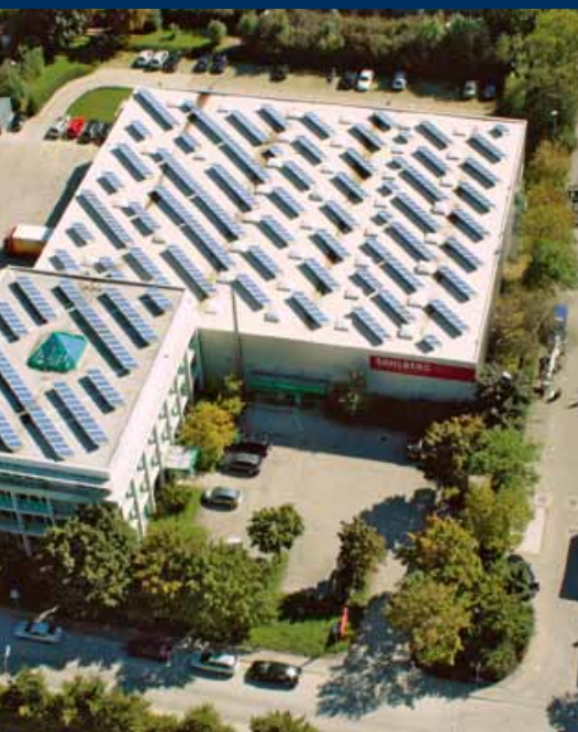
Zentrale und Lager 1
